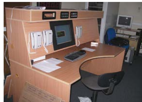
Рис. 6 - Пульт диспетчера пожарной охраны
