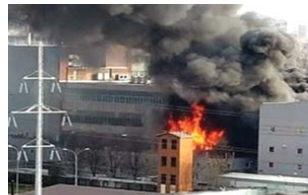
Рис.2 - Пожар на складе с ЛВЖ
