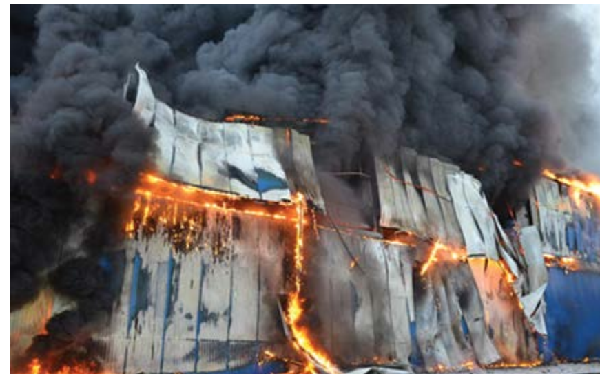
Рис.5 - Пожар в городе Красноярске ул. Пограничников 2012 год
